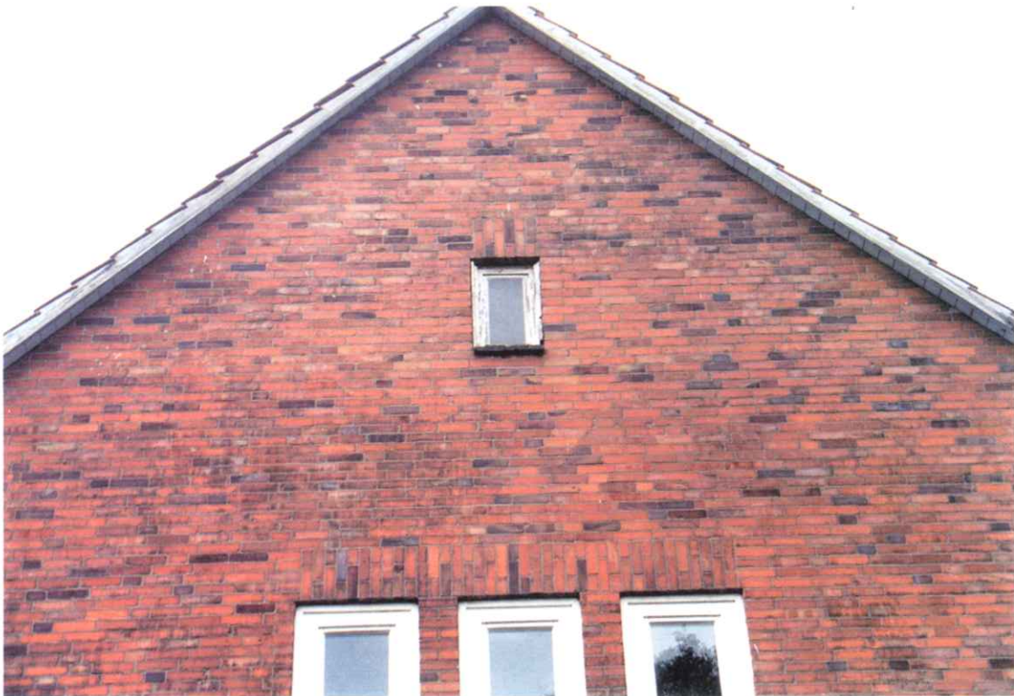
Bild 5: Giebelbereich Gebäude A, Süd-Südwestseite
