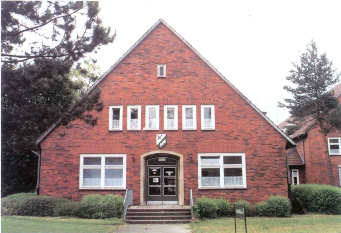
Bild 1: Fassadenansicht Gebäude A (Bundeswehrkaserne Wesendorf)
