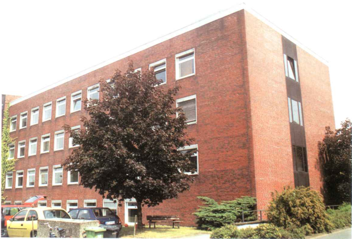
Bild 3: Fassadenansicht Gebäude B (sanierte Bereiche)
