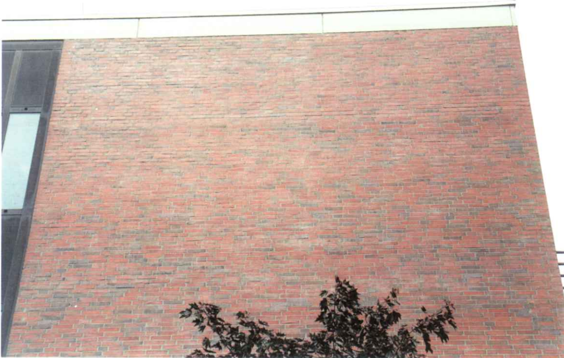
Bild 7: Giebelbereich Gebäude A, Süd-Südostfassade
