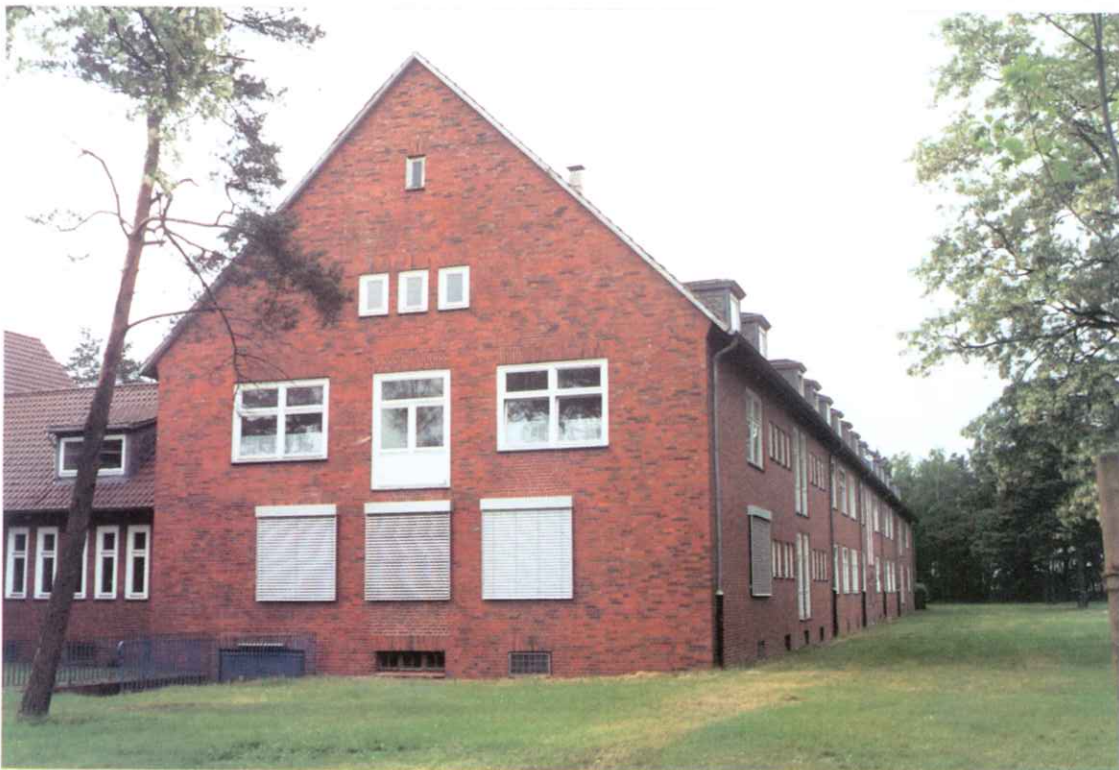
Bild 2: Fassadenansicht Gebäude A (Bundeswehrkaserne Wesendorf)
